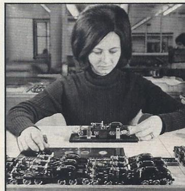
Einstellen des Fahrrichtungsschalters und Funktionsprüfung der Lok.
