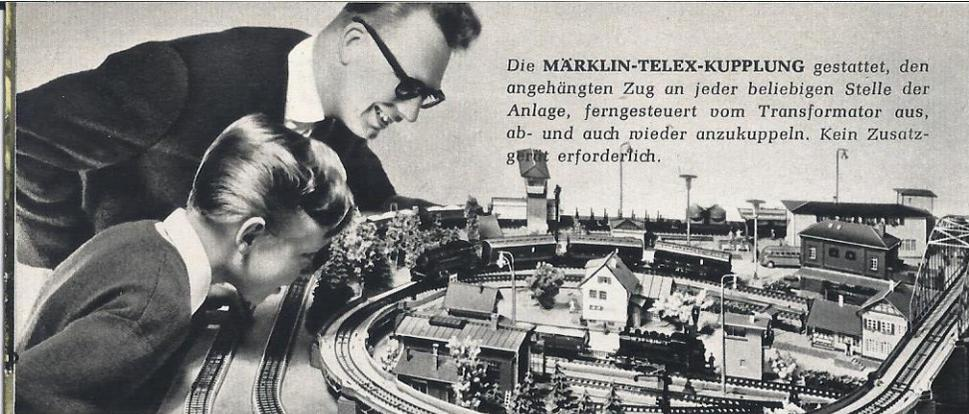
Die MÄRKLIN-TELEX-KUPPLUNG gestattet, den angehängten Zug an jeder beliebigen Stelle der Anlage, ferngesteuert vom Transformator aus, ab- und auch wieder anzukuppeln. Kein Zusatzgerät erforderlich.
